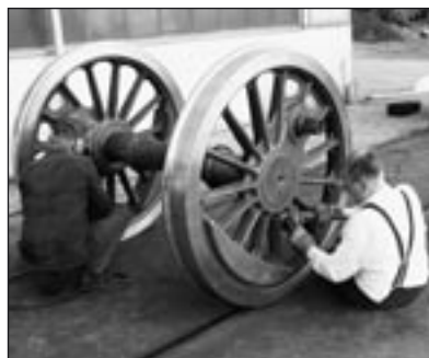
Diese „Gelegenheit“ wurde für eine Neulackierung der Radsätze und des Fahrwerks genutzt.
